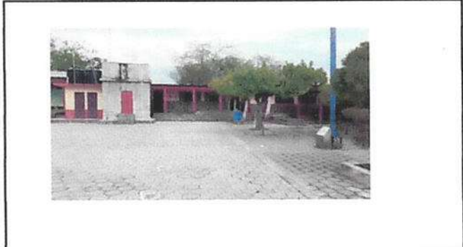
Foto 1; Se realizará la ampliación de cocina
